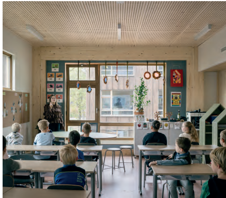
De plafonds in de leslokalen zijn van lignatuur-elementen.
