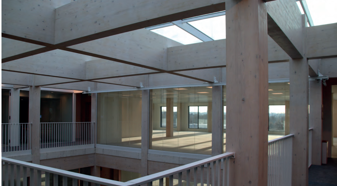
Bovenin het atrium: de dakconstructie is ook van hout.
