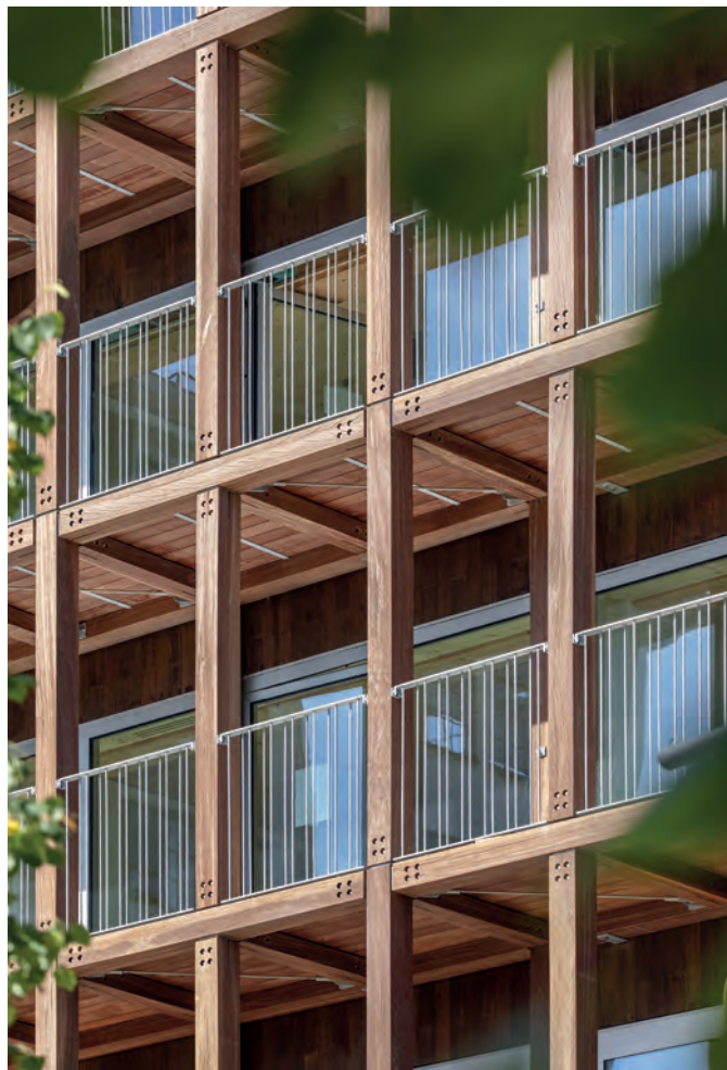
De buitenruimten zijn gemaakt met liggers van azobé en vloeren van massaranduba.
