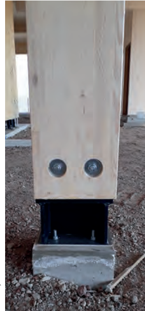
Met omgekeerde T-ankers op betonnen poeren zijn houten gelamineerde kolommen van 280 x 400 mm met verdiepte bouten gemonteerd.
