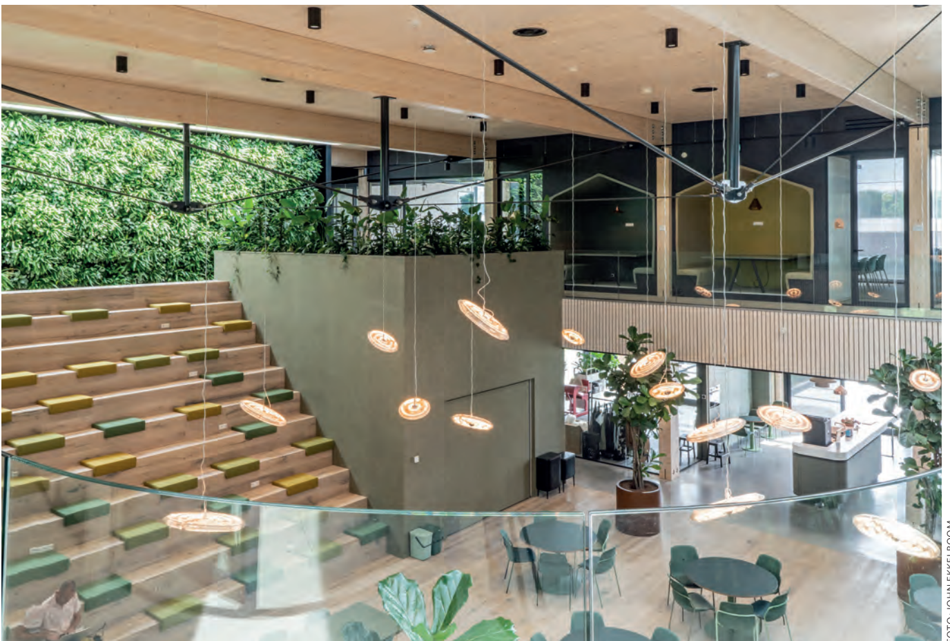
Het atrium is dé ontmoetingsplek voor medewerkers en bezoekers. Om de dakliggers daar niet groter dan 280 x 520 mm te hoeven maken zijn aan de onderkant van drie liggers stalen trekstangen bevestigd.
