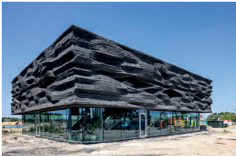
De bekleding van het Food Forum bestaat uit leem uit de Flevolandse klei. Daarachter zit isolatie van cellulose en daarachter bestaat de gevel uit CLT-panels.
