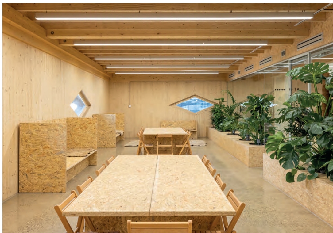
De meubels en aftimmering zijn deels van OSB-plaatmateriaal gemaakt. Verder is het CLT en de glulam in het zicht gelaten.
