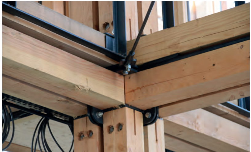
Constructie met volhout balken van douglassparren. De stalen knopen zijn goed losmaakbaar.
