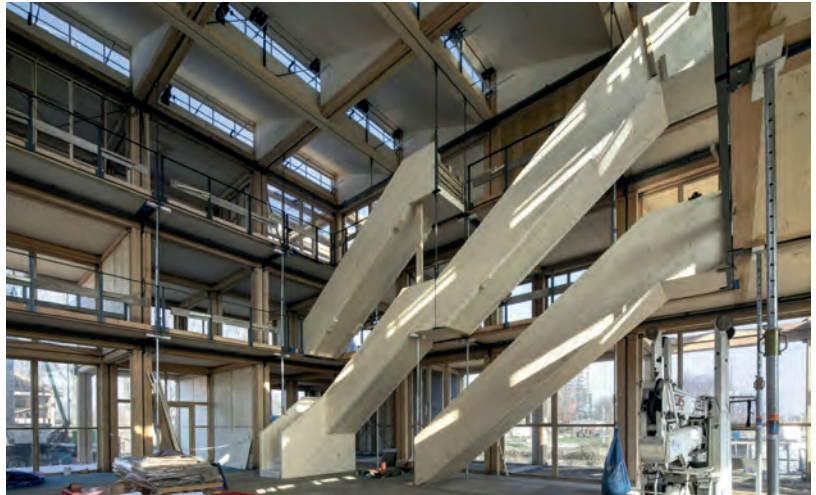
De indrukwekkende trappen werden uit 1 plaat CLT gezaagd en voorzien CLT leuning.
