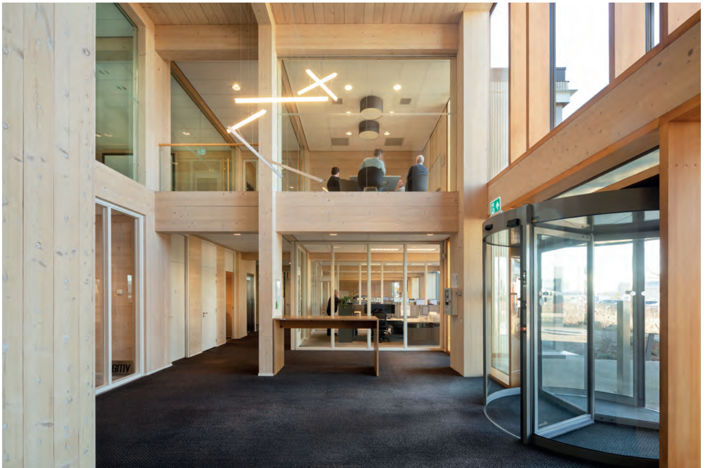
De entreehal in de oudbouw. De kolommen rond de ramen lijken heel massief, maar er zitten koven omheen gemaakt van heel dunne CLT waarachter leidingen (o.a. ventilatie) lopen. De DLT wanden hebben een zichtkant en een kant met deuvels, zoals links.
