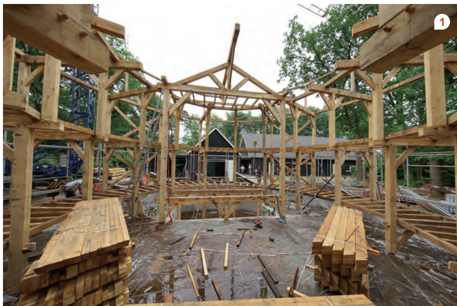
1 // De nokligger boven het podium vormde constructief een uitdaging. 2 // Houten windverbanden zijn ingelaten in de balkconstructie onder de verdiepingsvloer van de rondgang. 3 // De rondgang heeft een hellend dak gekregen. 4 // Het hart van het gebouw is voorzien van een glaskap, waarmee de openheid bewaard blijft.
