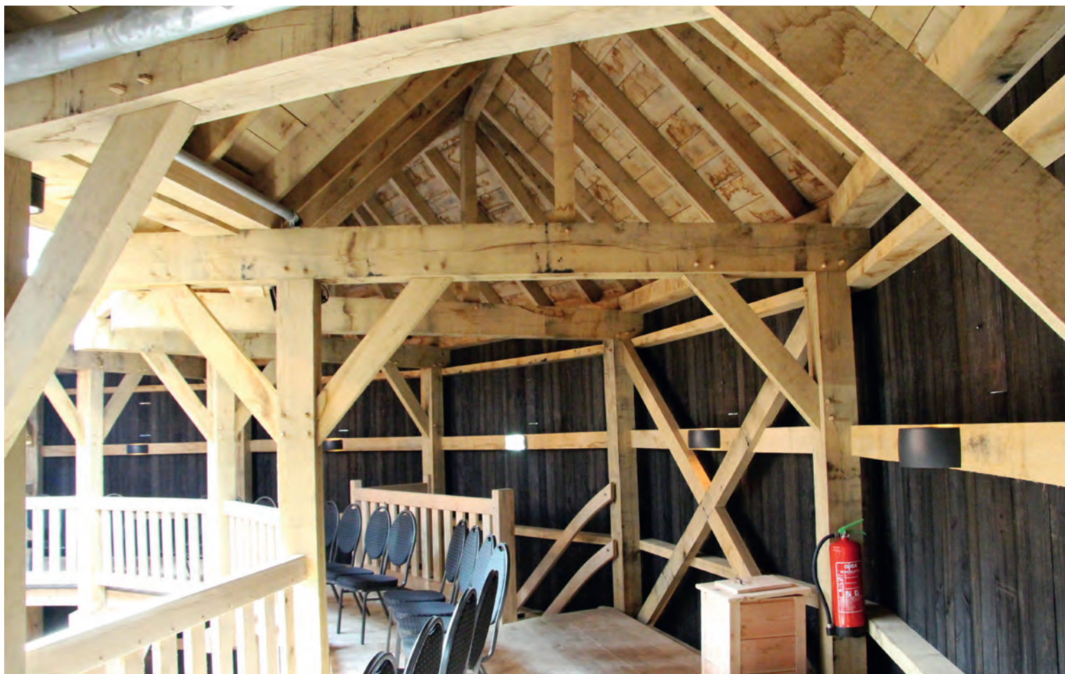
In de gevel zijn houten windbokken opgenomen. Op halve hoogte van de gevel bevindt zich een getimmerde houten leidinggoot. De stoeltjes zijn tijdelijk en worden nog vervangen.
