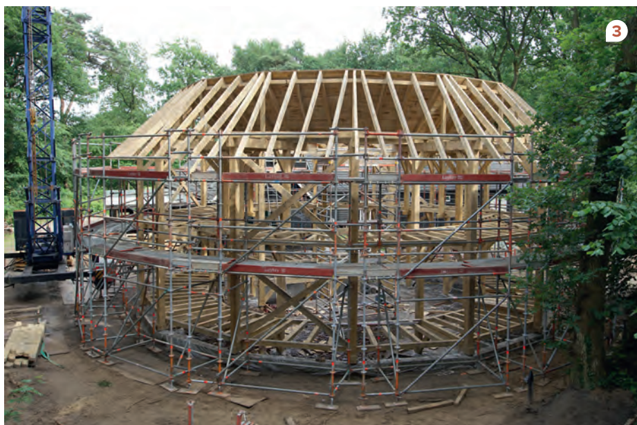
1 // De nokligger boven het podium vormde constructief een uitdaging. 2 // Houten windverbanden zijn ingelaten in de balkconstructie onder de verdiepingsvloer van de rondgang. 3 // De rondgang heeft een hellend dak gekregen. 4 // Het hart van het gebouw is voorzien van een glaskap, waarmee de openheid bewaard blijft.
