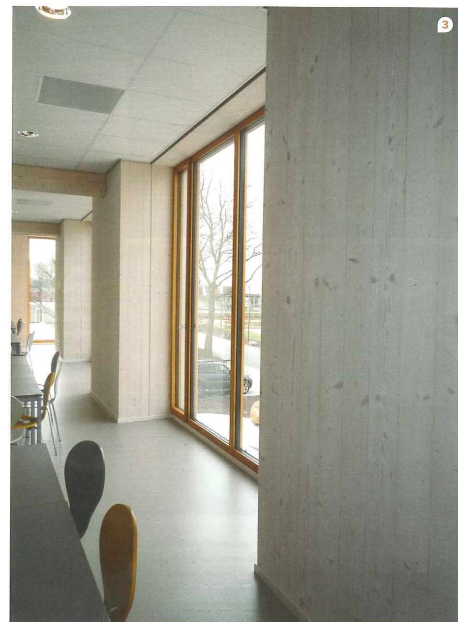
1 // De gevel is bekleed met Accoya-puien met gezette en gecoate stalen raamkaders tussen de prefab Nur-Holz-elementen. 2 // Een levende groene wand zet CO 2 – dat wordt geproduceerd door de medewerkers – om in zuurstof. 3 // De ventilatielucht wordt ingeblazen boven het verlaagde plafond en komt via een aantal ventilatieroosters zonder tocht in de ruimte. Voor verticaal leidingtransport zijn vrijwel onzichtbare leidingsschachten in de houten gevelzone opgenomen.
