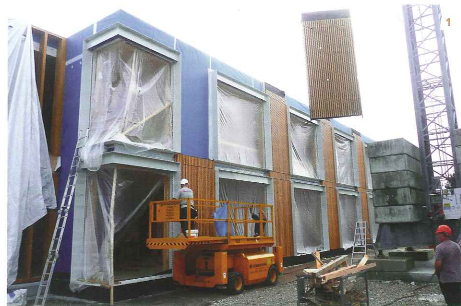
1 // De gevel is bekleed met Accoya-puien met gezette en gecoate stalen raamkaders tussen de prefab Nur-Holz-elementen. 2 // Een levende groene wand zet CO 2 – dat wordt geproduceerd door de medewerkers – om in zuurstof. 3 // De ventilatielucht wordt ingeblazen boven het verlaagde plafond en komt via een aantal ventilatieroosters zonder tocht in de ruimte. Voor verticaal leidingtransport zijn vrijwel onzichtbare leidingsschachten in de houten gevelzone opgenomen.
