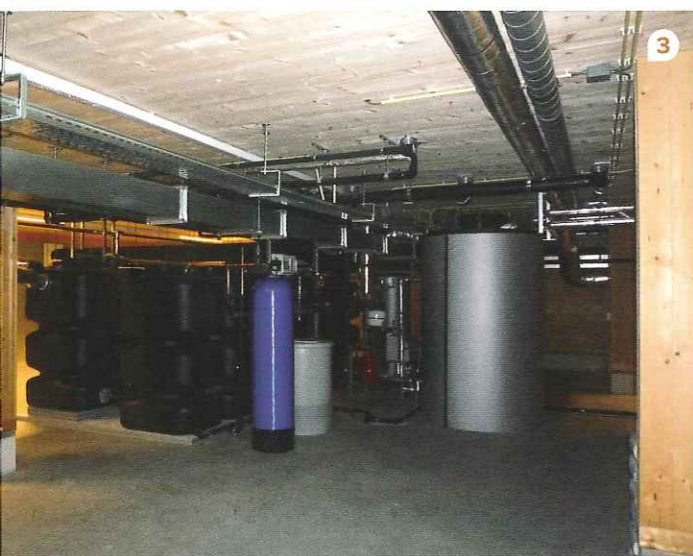
1 // De duurzaamheid van het terrein rondom is meegenomen in het ontwerp. Er staan insectenhôtels, er hangen vleermuiskasten en er is een amfibiepoel. 2 // Alle leidingen zijn in de houten panelen weggewerkt. 3 // In de kelder staat een opslag voor 10.000 liter regenwater voor toiletspoeling en bewatering van de groene wand. Het ophangen van de installaties was gemakkelijk, omdat overal geschroefd kon worden.
