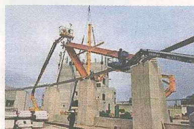
De koepels zijn opgebouwd per prefab driehoek dus zonder spantconstructie in de bolvorm. Foto: Rubner Holzbau
