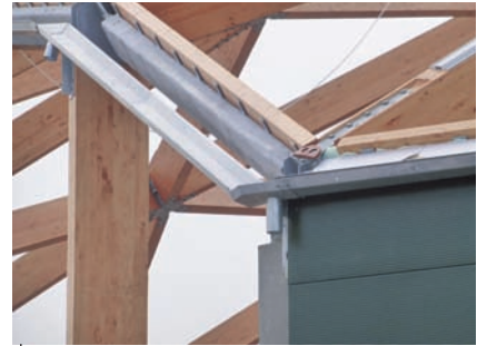
Hemelwater wordt opgevangen in een gootconstructie die parallel loopt aan de trekkring.
