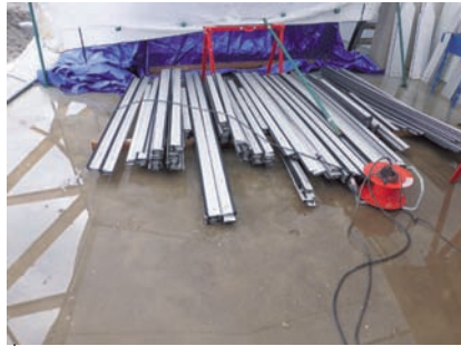
En de aluminium deksels met aan één zijde een rubberprofiel, waarmee het geheel aansluit op de luchtkussens.
