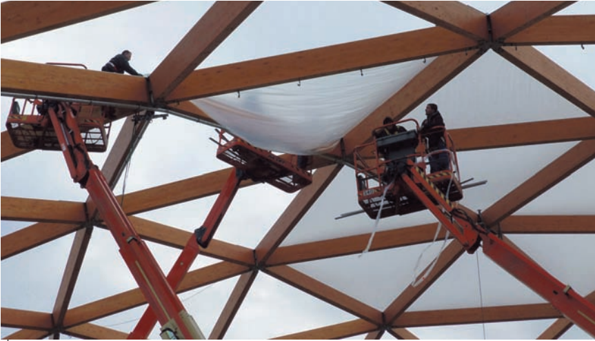
De kussens worden samengesteld uit twee folies die ter plekke worden gespannen en vastgezet in aluminium profielen.
