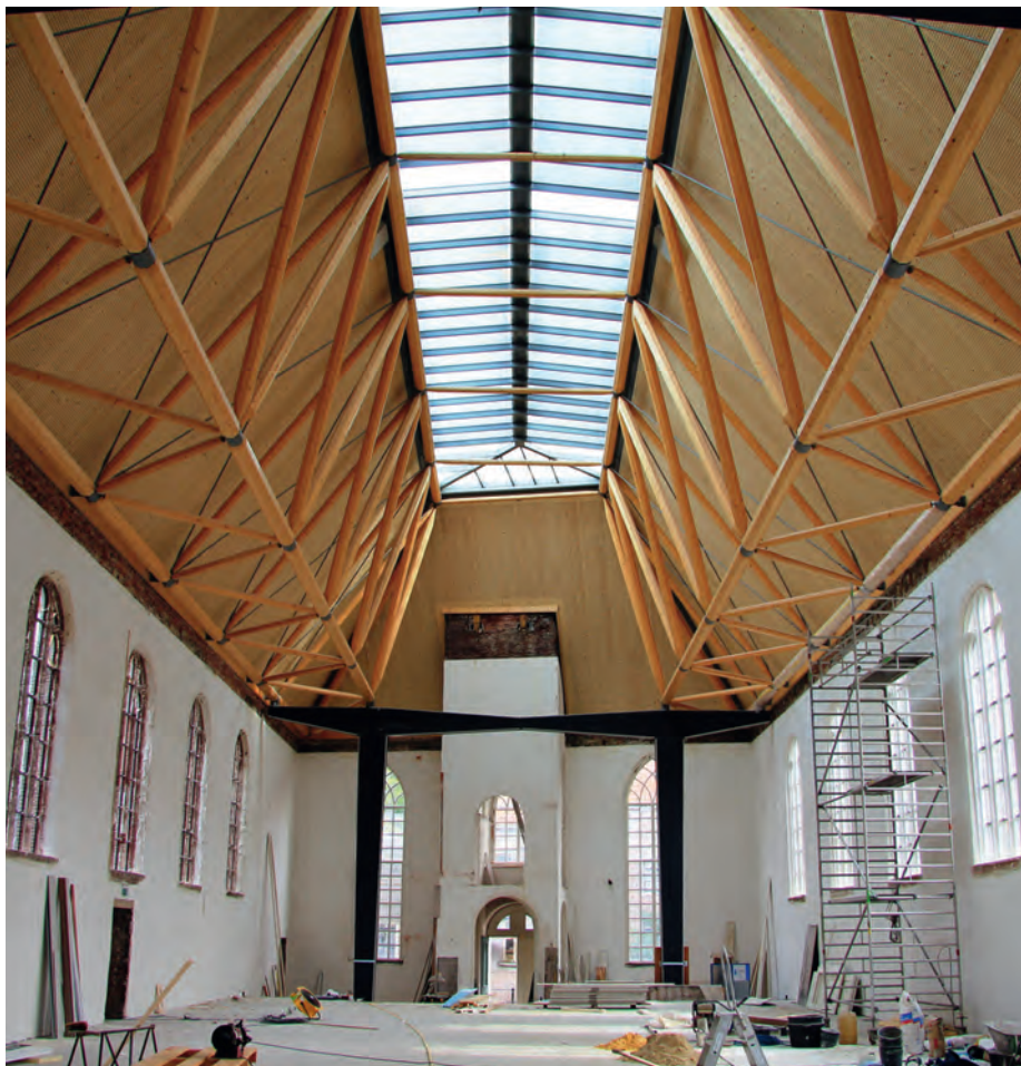
Het vakwerkspant lijkt symmetrisch maar heeft grote verschillen, onder meer doordat de gevels niet evenwijdig lopen en de voorgevel schuin geplaatst is.
