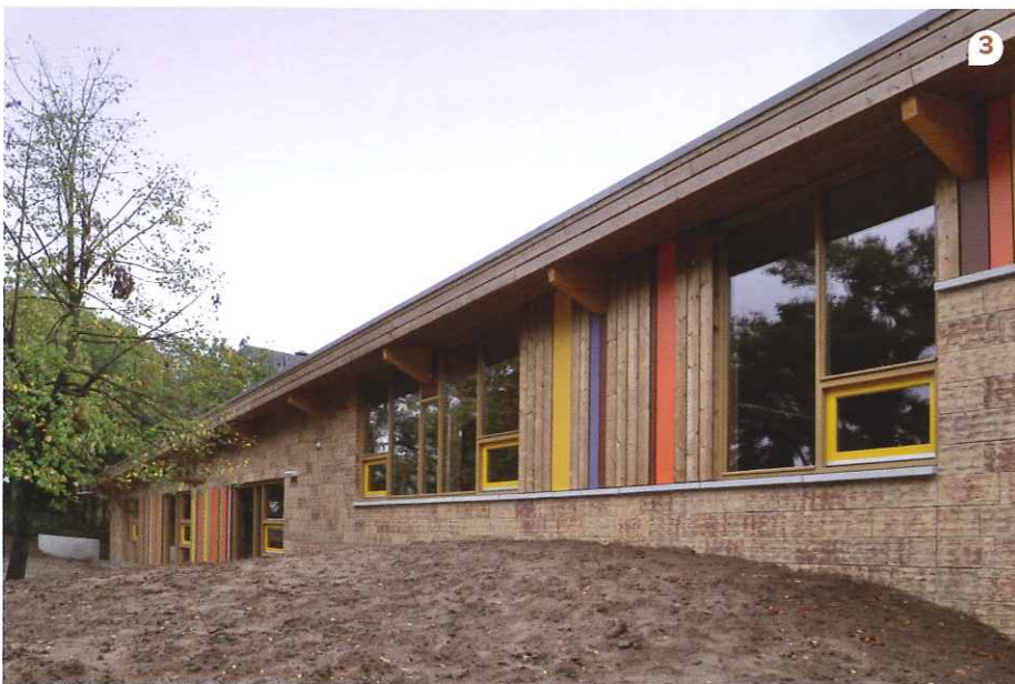
4 // De lokalen van de school zijn op het noorden gesitueerd; de gangzone aan de zuidzijde fungeert als warmtebuffer. De lokalen hebben grote ramen op het noorden. Aanvullend zijn Solarspots toegepast in combinatie met daglichtgerегelde tl-verlichting. Voor een gezond klimaat is in scholen veel ventilatie nodig. Om dat duurzaam te doen, is gekozen voor aanvoer van lucht via een bodemwisselaar, die in de winter de lucht voorverwarmt en in de zomer juist koelt. De lucht wordt CO 2 -gestuurd afgezogen. Verwarming en koeling wordt gedaan middels een warmtepomp met bodemcollector.
