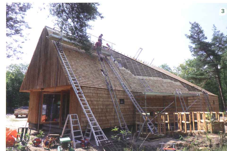
1 // Als gevolg van de verbreding in de plattegrond heeft de helft van de 18 gelamineerde vuren houten spanten (120 x 300 mm) elk een andere vorm. 2 // De binnenwanden zijn afgewerkt met tweedehands vuren vloerdelen, waarvan de bevestiging precies achter de spanten valt. 3 // Een knik in het dak- en gevelvlak markeert de overgang tussen het 7 meter smalle entreegedeelte en de 11 meter brede kerkzaal. 4 // Glazen vinnen aan de binnenkant van de achterpui (vliesgevel) moeten de winddruk en trekbelasting opvangen. 5 // Het bovenste deel van de voorpui is uitgevoerd als roostergevel, terwijl de entree met taatsdeuren volledig uit glas bestaat.
