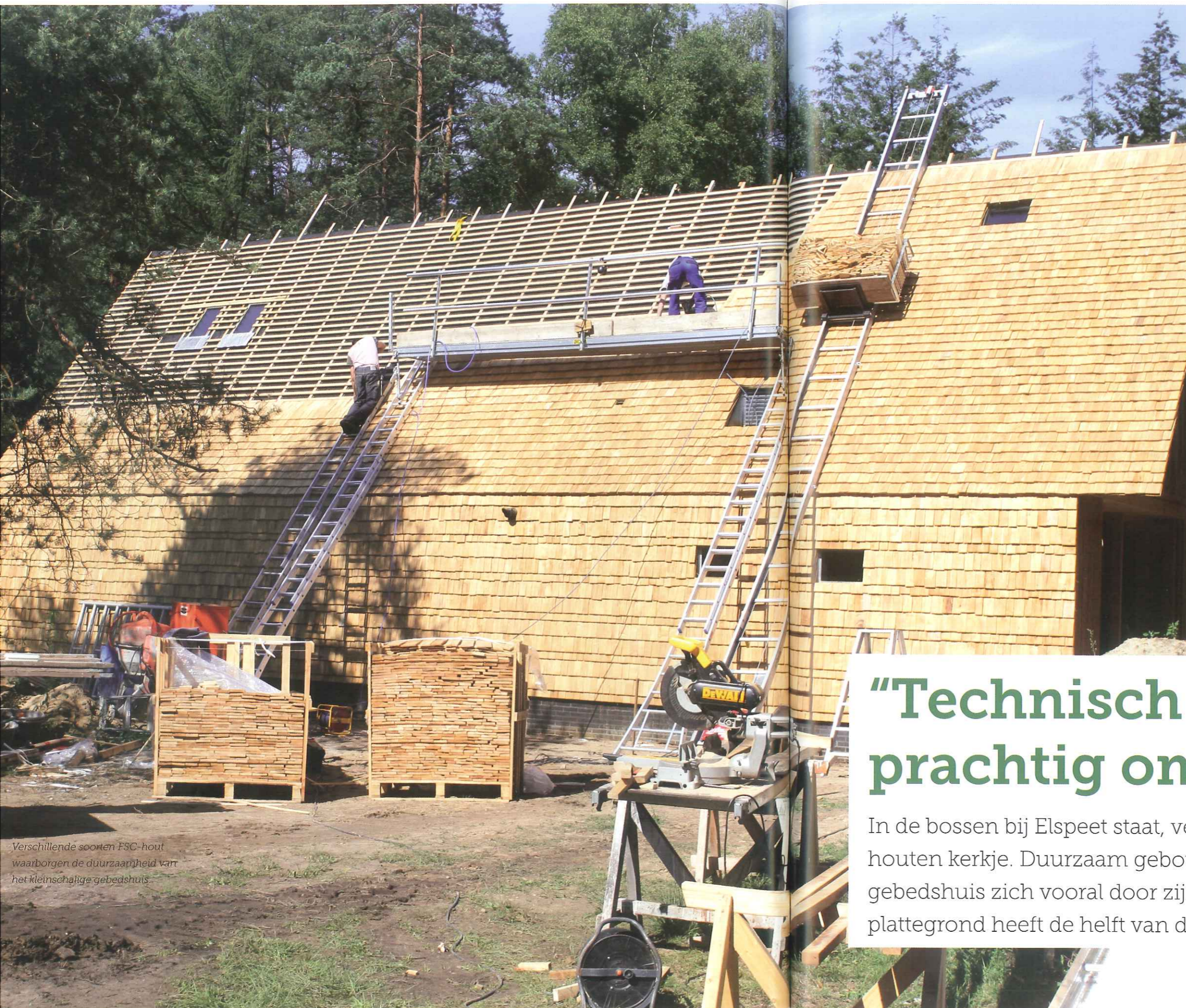
Zowel het dak als de gevels zijn trapsgewijs bedekt met shingles van Frans acaciahout.
