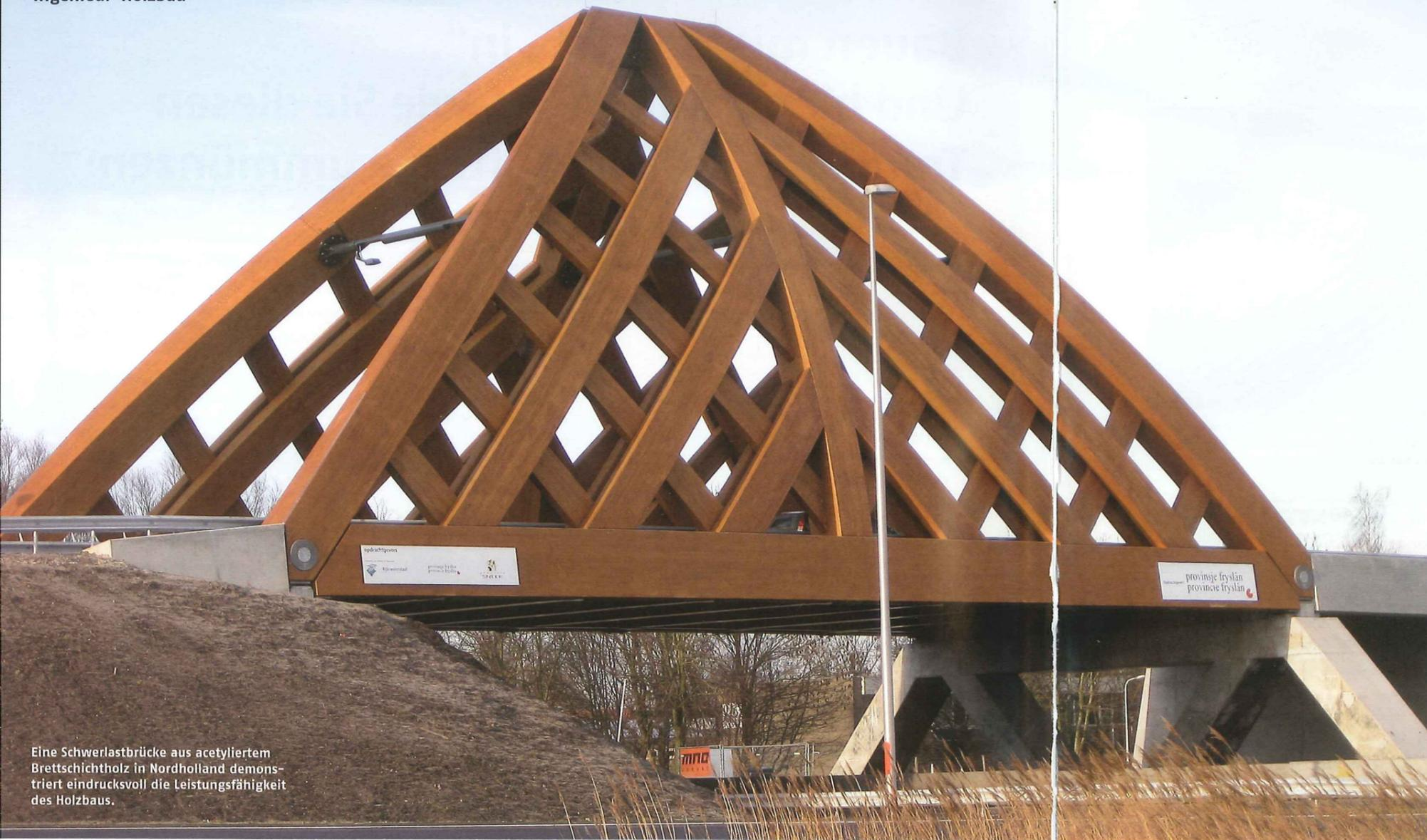
Eine Schwerlastbrücke aus acetyliertem Brettschichtholz in Nordholland demonstriert eindrucksvoll die Leistungsfähigkeit des Holzbaus.
